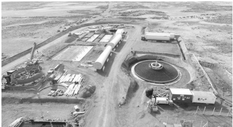
그림 4 텍사스주 내 E-연료 생산 플랜트 건설 현장
