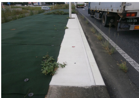
[시공 1년 경과 후]
